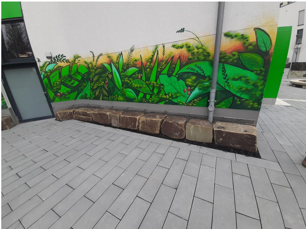
Abbildung 4 - sickerfähiges Pflaster ohne Fugenaufweitung am Hermann-Löns Forum
