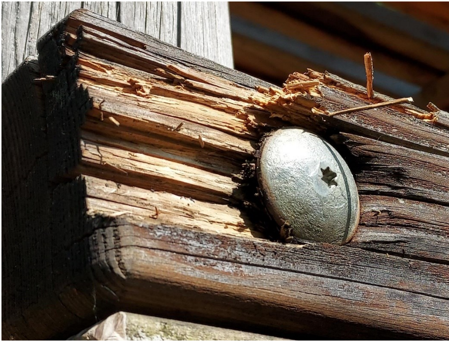
Dieses Foto zeigt einen der Schäden am Spielgerät.
