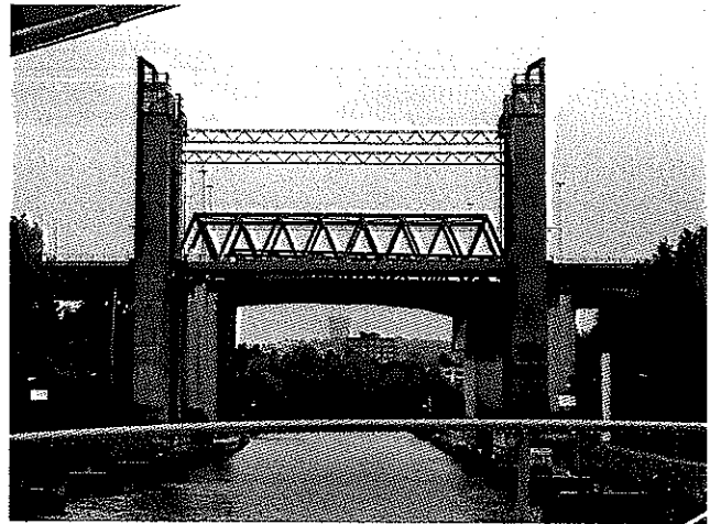
Abb. 1.18: Bewegliche Brücke – maschinelle oder elektrische Anlagen sind nach speziellen Vorschriften zu prüfen (Quelle: Liselotte Höckendorff, Brühl)
