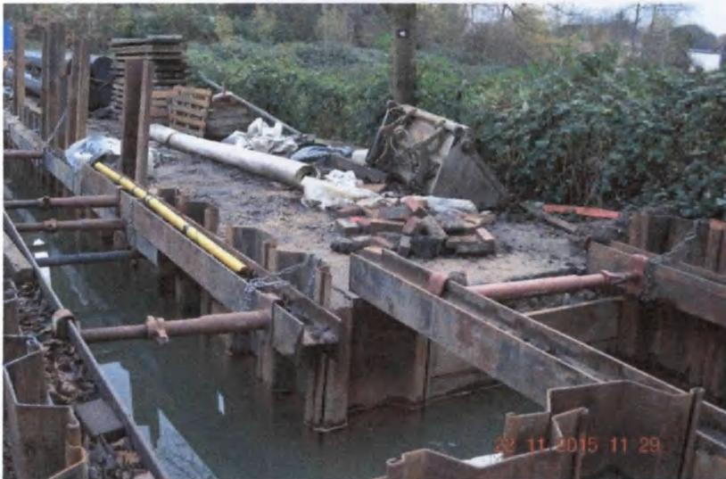
Diese hohe Niederschlagsmenge verschärfte die Schichtenwasserproblematik und sorgte für eine monatelange Stilllegung der Baugrube, da das permanente Abpumpen des einströmenden Wassers zu einer Unterspülung der Straße führte. Ein Müllabfuhrfahrzeug durchbrach mit einer Achse die Straßendecke. Erst nach aufwändigem Einbringen von Spundwänden in die Baugrube, die zudem mit Querstreben stabilisiert werden mussten, konnten die Arbeiten fortgeführt werden.
