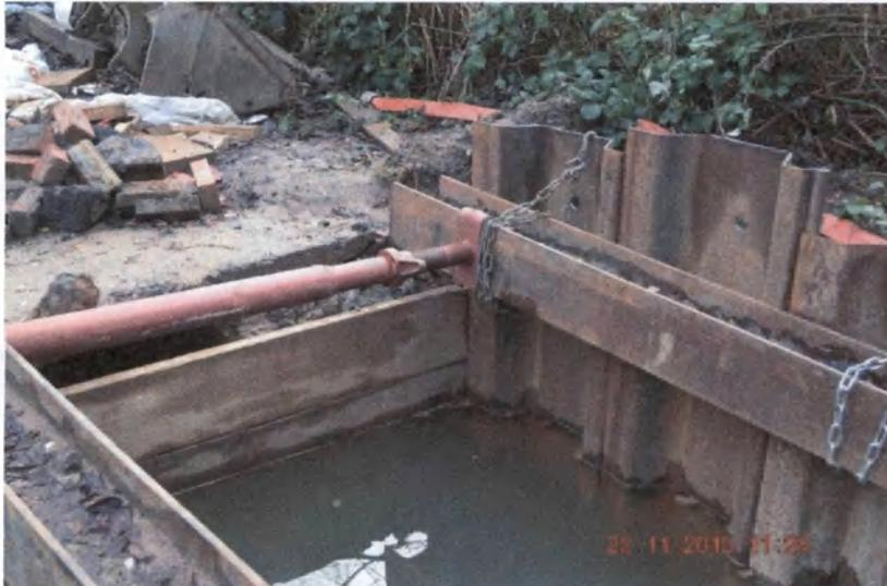
Zu einer gefluteten Baugrube führte auch die Erneuerung der Haupttrinkwassertransportleitung im November 2015 direkt an der Pferdewiese. Der Monat November 2015 hatte ein überdurchschnittliche Niederschlagsmenge von 131 % (Quelle: wetterkontor.de).
