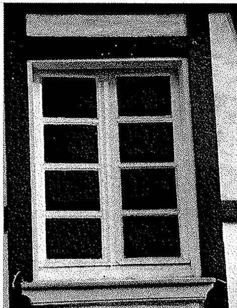
Alle Sprossenfenster im OG noch original aus der Bauzeit: mit Wolfsrachen am Stulp und Espagnolette-Verschlüssen; einfaches Fensterfutter mit Profileiste unter Fensterbank
