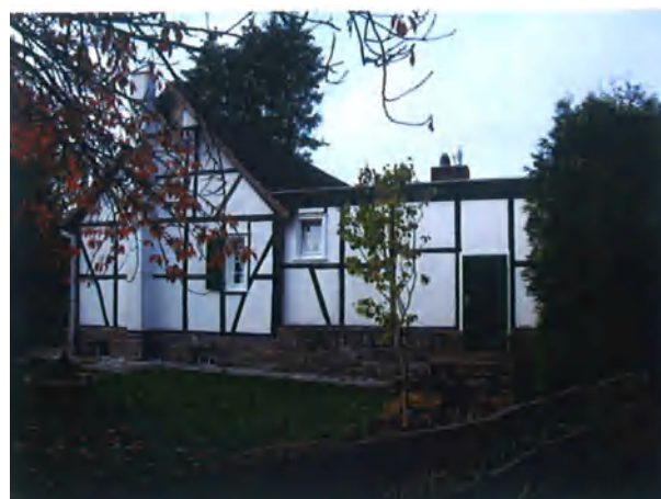
Giebel des Fachwerkgebäudes
