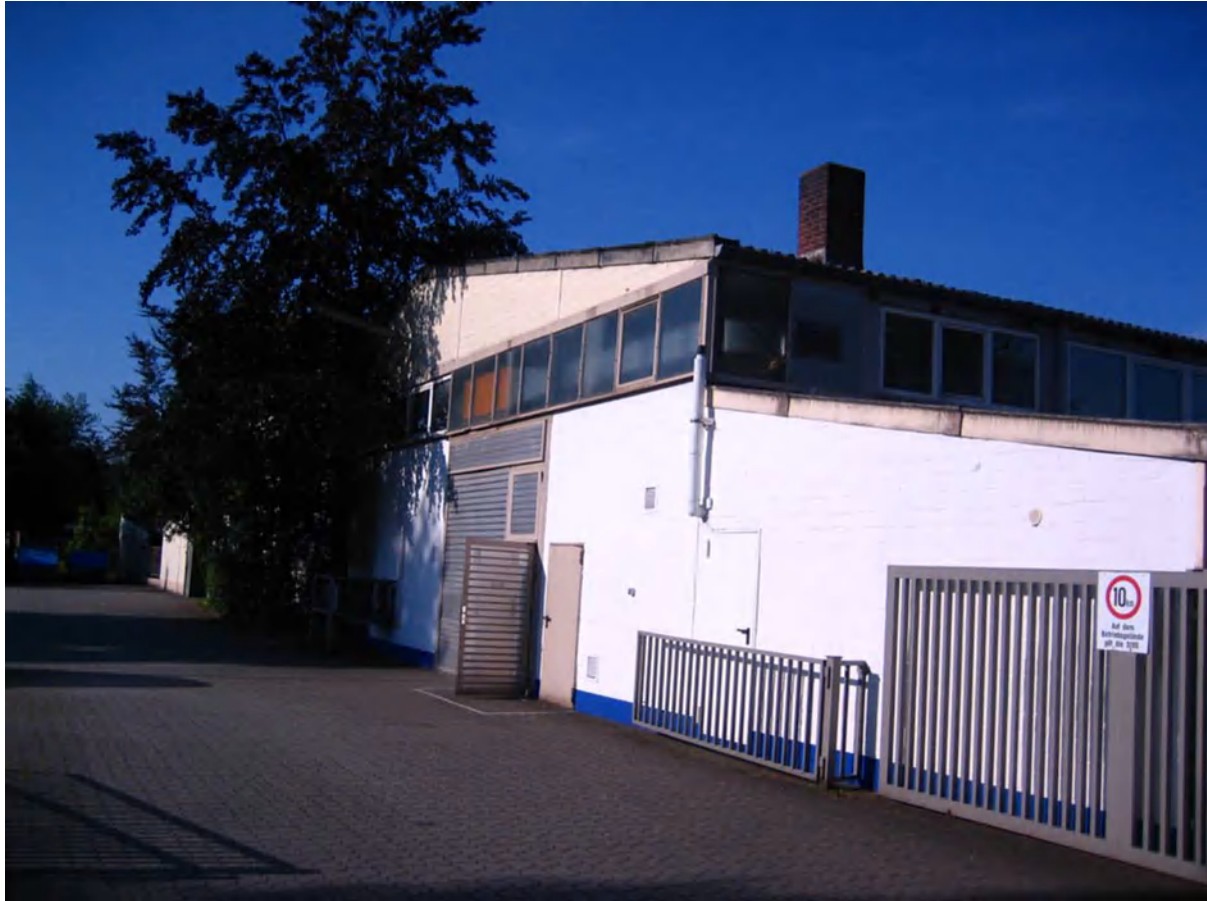
Die Halle an der Tannenbergsstraße 53
