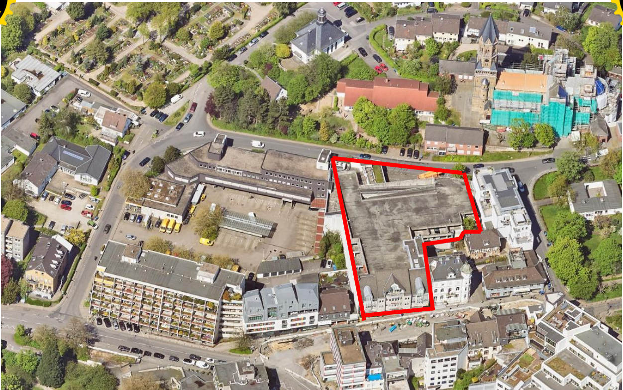
Luftbild Blickrichtung Norden
