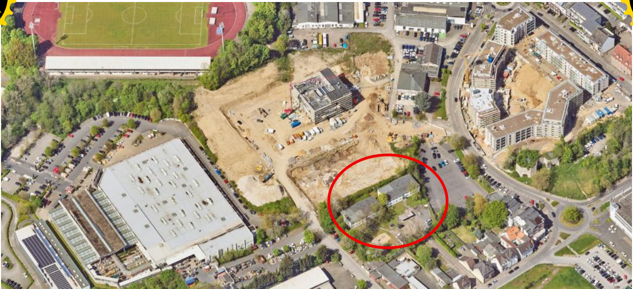
Luftbild Blickrichtung Norden
