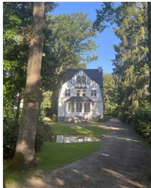
Abb. 4 Parkstraße 6 Vorgarten- zone
