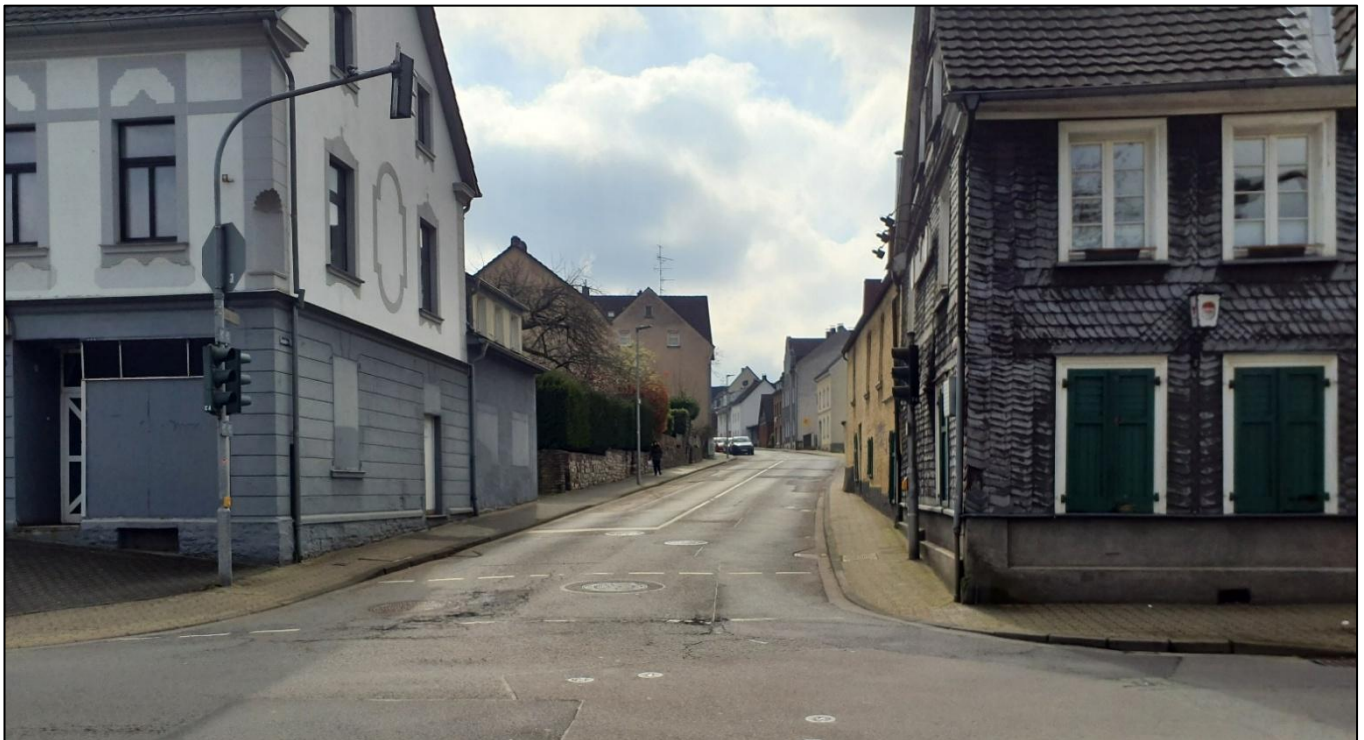
Abbildung 10: Blick auf die Sander Straße vom Knotenpunkt Sander Straße / Hauptstraße nach Süden, auffällig sind die geringen Gehwegbreiten, insbesondere auf der westlichen Seite (hier rechts)
