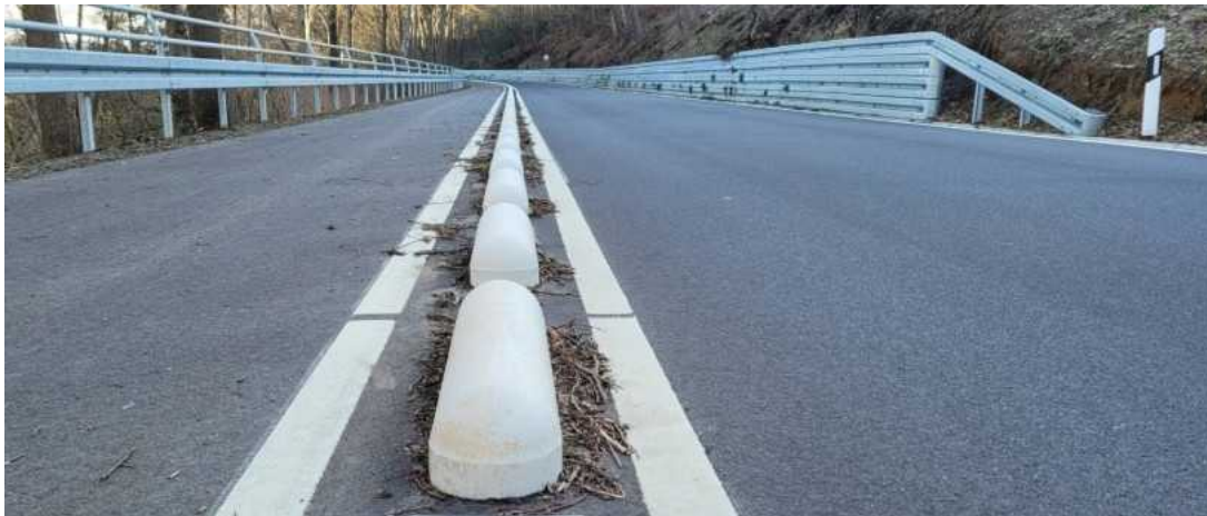
Abbildung 2: Beispiel für Betonschwellen als Abgrenzung zur Fahrbahn aus der Stadt Hückeswagen (Quelle: https://rp-online.de/nrw/staedte/hueckeswagen/hueckswagen-nach-sommerferien-wird-radweg-gebaut_aid-48962179 )
