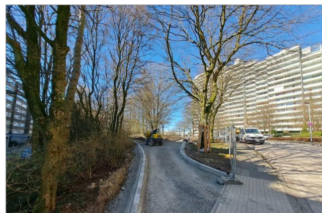
Abbildung 24: Umgestaltung Quartiersplatz Wohnpark im Bau, März 2026 (Quelle: Stadt Bergisch Gladbach)
