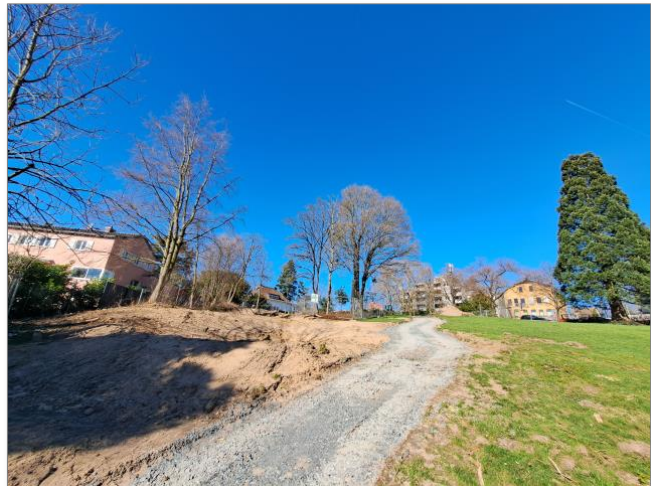
Abbildung 12: Deutscher Platz, Baubeginn im Planbereich Spielfläche (Quelle: Stadt Bergisch Gladbach, März 2026)
