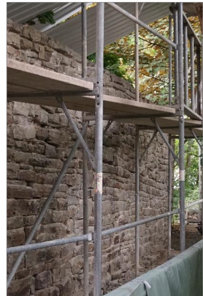
Abbildung 14: Burggraben – Herrichtung der Burgmauer (2. Bauabschnitt) (Quelle: DSK)
