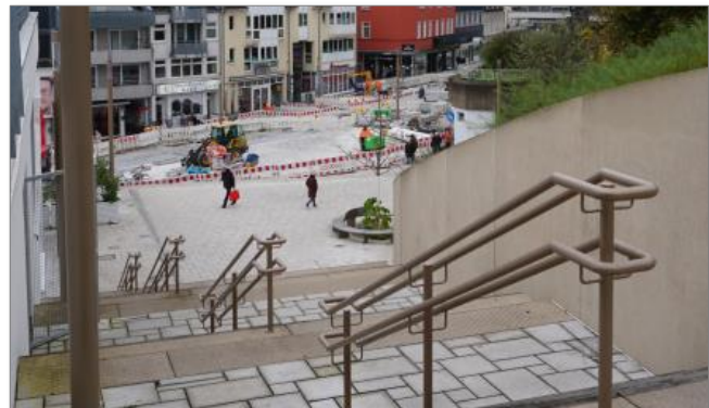
Abbildung 8: Pflasterung der Zwischenebenen mit Naturstein, Anbringung Geländer (Bildquelle: DSK GmbH, Nov. 2024)
