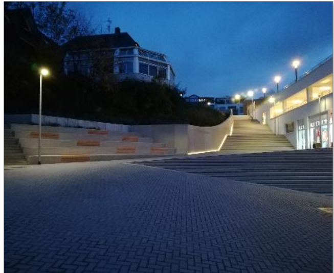
Abbildung 7: Bauabschnitt 1 der Schloßstraße: fertiggestellte Treppenanlage (Bildquelle: Stadt Bergisch Gladbach, Okt. 2020)
