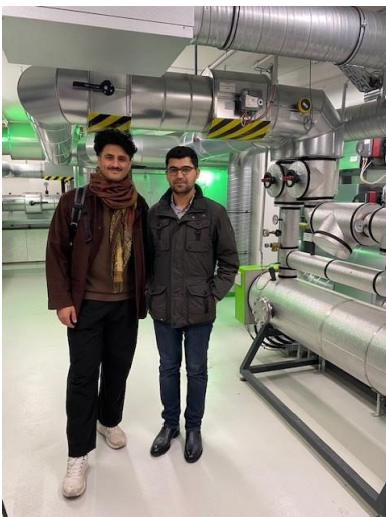
Abbildung 4 Großwärmepumpe Köln Ehrenfeld (Stadt Bergisch Gladbach)
