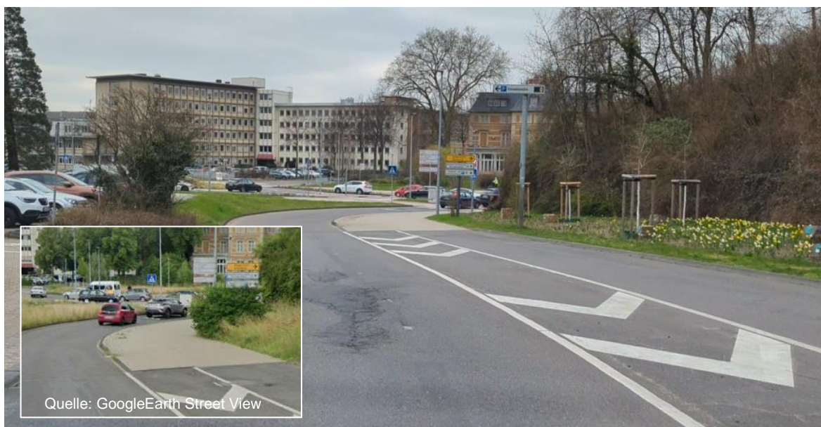
Bild 20: Bypass Bensberger Straße Innenkurve / Grünwuchs
