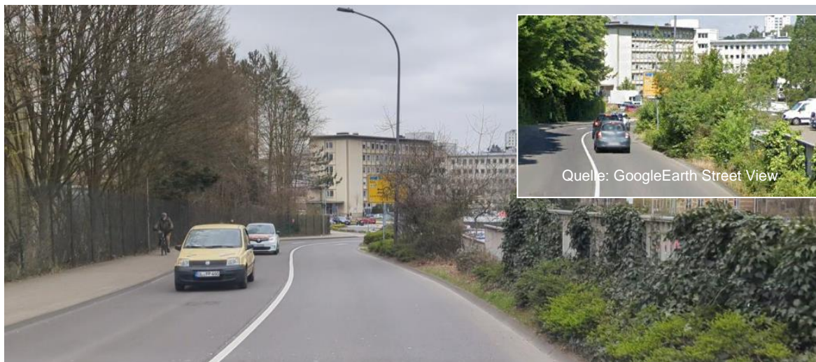
Bild 21: Erkennbarkeit FGÜ Bensberger Straße
