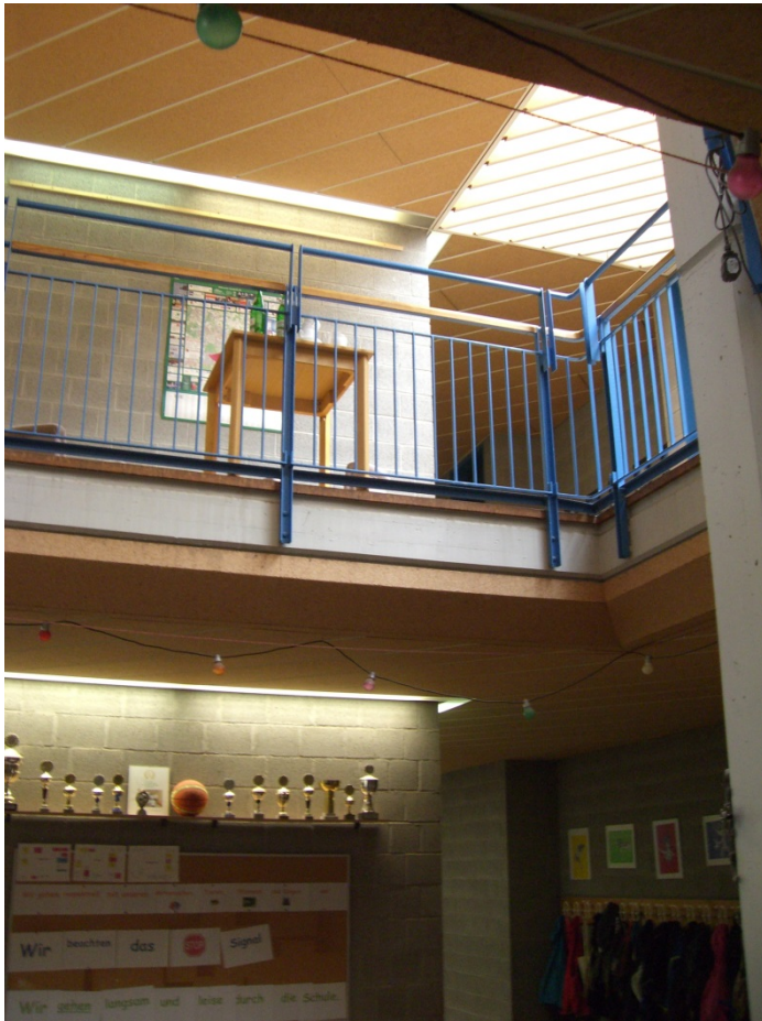
Abb.: Grundschule „An der Strunde“
