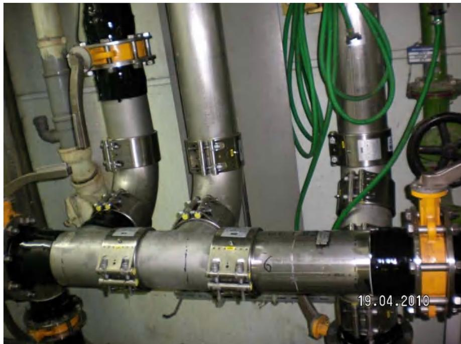
**Abbildung 1: Im Treppenhaus verlaufende Gasleitungen mit Reparaturmanschetten**
